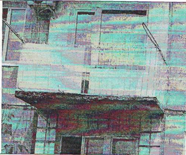
Фото 9,10. Разрушение, сколы граней балконных плит.
