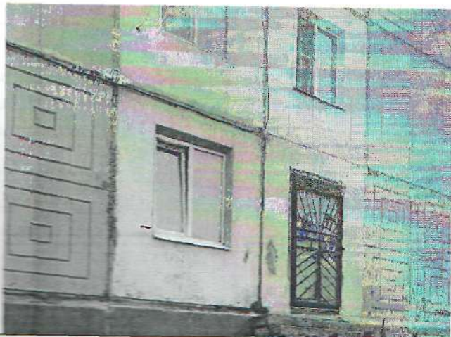
Фото 7,8. Выветривание межпанельных стыков наружных стен здания.
