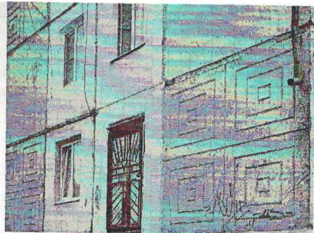
Фото 7,8. Выветривание межпанельных стыков наружных стен здания.
