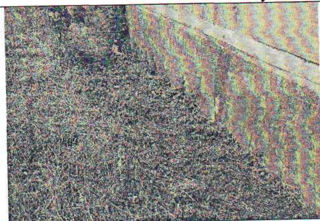
Фото 3,4. Отмостка. Следы растительности, трещины и разрушения, проседание неплотное прилегание отмостки к цоколю здания, что способствует проникновению влаги и дальнейшему замачиванию фундаментов, что не соответствует требованиям п. 6.26 СП 82.13330.2016 «Благоустройство территорий».
