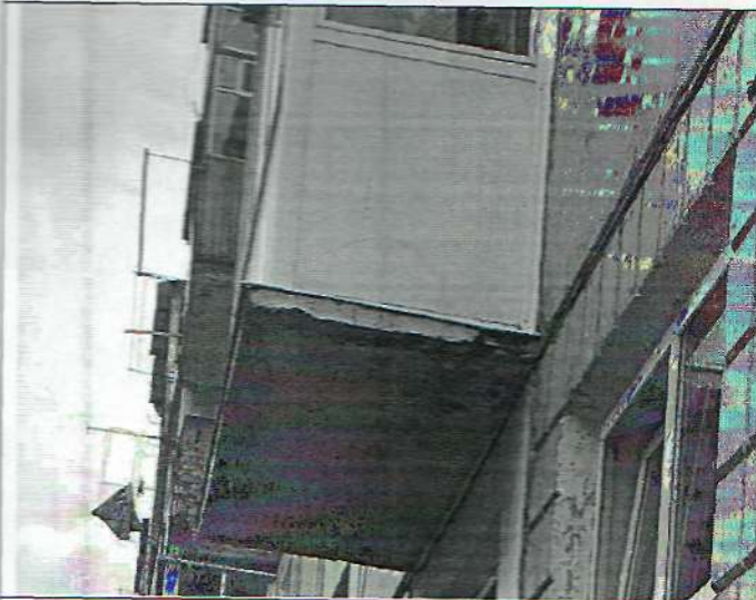
Фото 9,10. Разрушение, сколы граней балконных плит.
